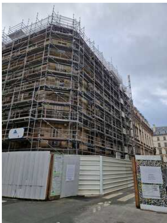
Travaux de réhabilitation de la rue de Trévis actuellement menés.
